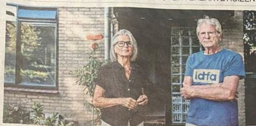
In het huis van Francien van Hulsten en Jan Bergmans zitten overal scheuren. FOTOS: JAN VAN DEN BERG
